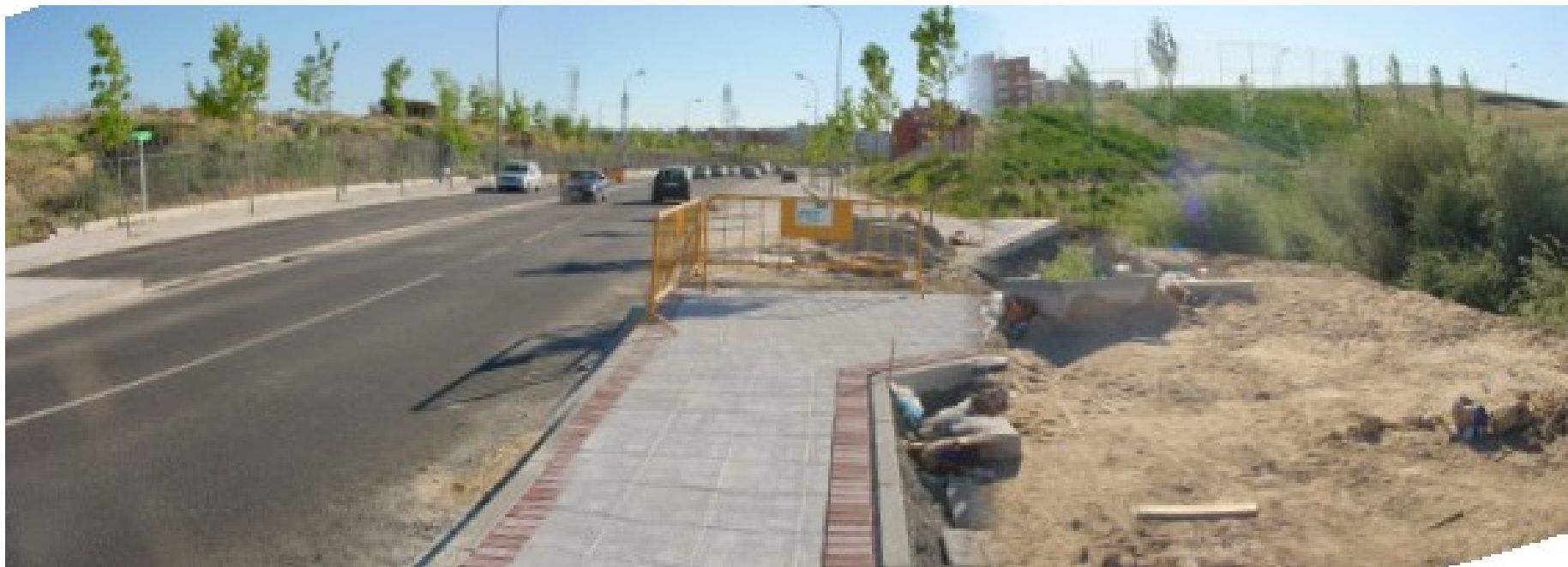
FOTO 1. Cruzamiento del arroyo de Valdelasfuentes por la calle de Francisco Largo Caballero mediante entubamiento en el límite del término municipal de Alcobendas.
