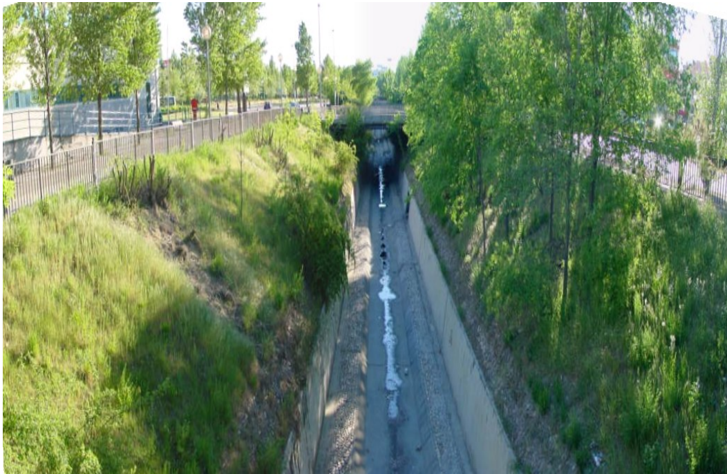
FOTO 16. Vista del encauzamiento realizado en la zona del parque urbano. Las aguas provenientes de las cuencas situadas aguas arriba del arroyo de la Vega van encauzadas a través de dos marcos prefabricados enterrados bajo el encauzamiento de la fotografía.
