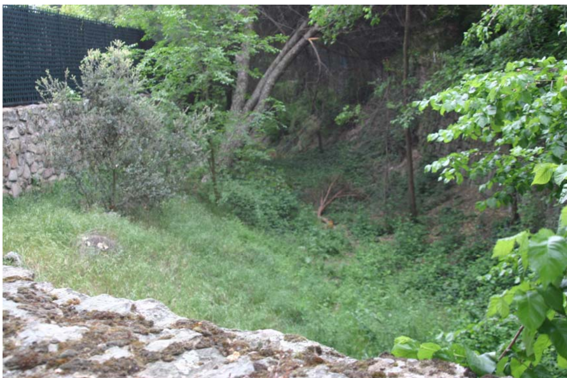
FOTO 2. Vista aguas arriba inicio de cabecera de cuenca del arroyo de Valdeviviendo.
