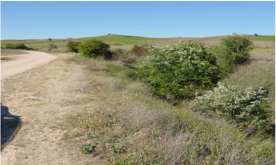
FOTO 3. Vista del arroyo de Valdelacasa aguas arriba a la altura del Monte Valdelatas, presentando un cauce amplio bien definido, con un lecho de 2 m. de anchura y taludes tendidos a 45°.
