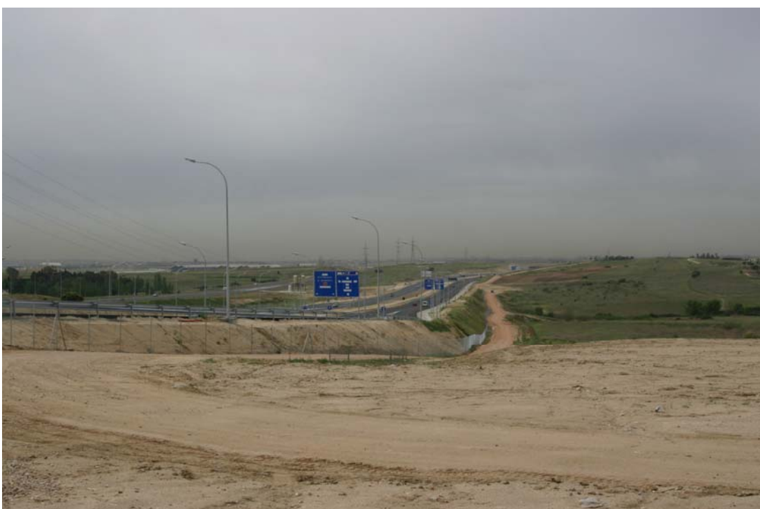
FOTO 2. Vista del arroyo Mesones inmediatamente aguas arriba de la autopista R-2
