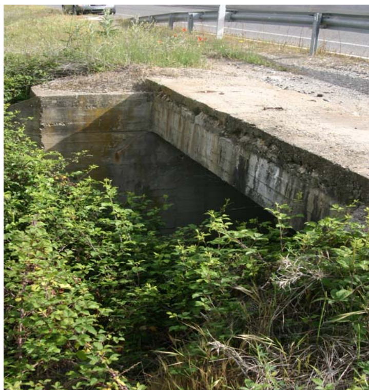
FOTO 13. Vista de detalle aguas arriba de obra de drenaje de la carretera M-110, formada por marco de hormigón armado de sección libre 3,00*2,00 m.
