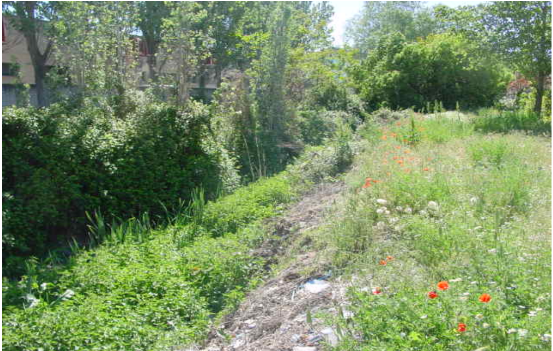
FOTO 10. Aguas arriba del arroyo de la Vega desde la obra de paso de la C/ Francisco Gervás. Se observa una gran cantidad de maleza que invade el cauce y ambas márgenes.
