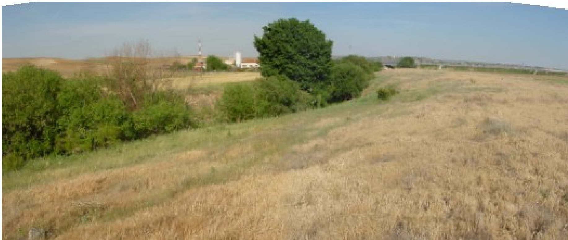
FOTO 26. Vista del arroyo de la Vega aguas abajo de la E.D.A.R. en la margen izquierda. El cauce es muy amplio y profundo, con taludes prácticamente verticales con unas alturas medias entre 5 y 6 m.
