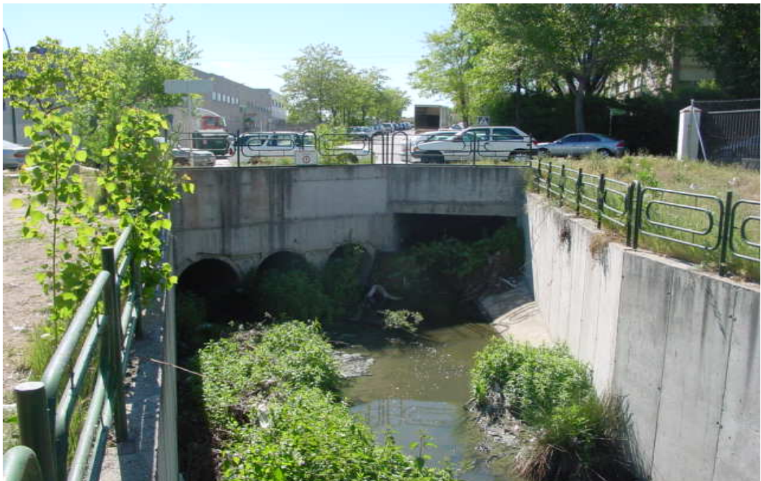
FOTO 5. Detalle de la obra de drenaje formada por un conjunto de tres tubos de 1,50 m. de diámetro y una tarjea rectangular de hormigón de 3,00*1,00 m. de sección libre esviada respecto a los tubos, y embocadura formada por aletas de hormigón.
