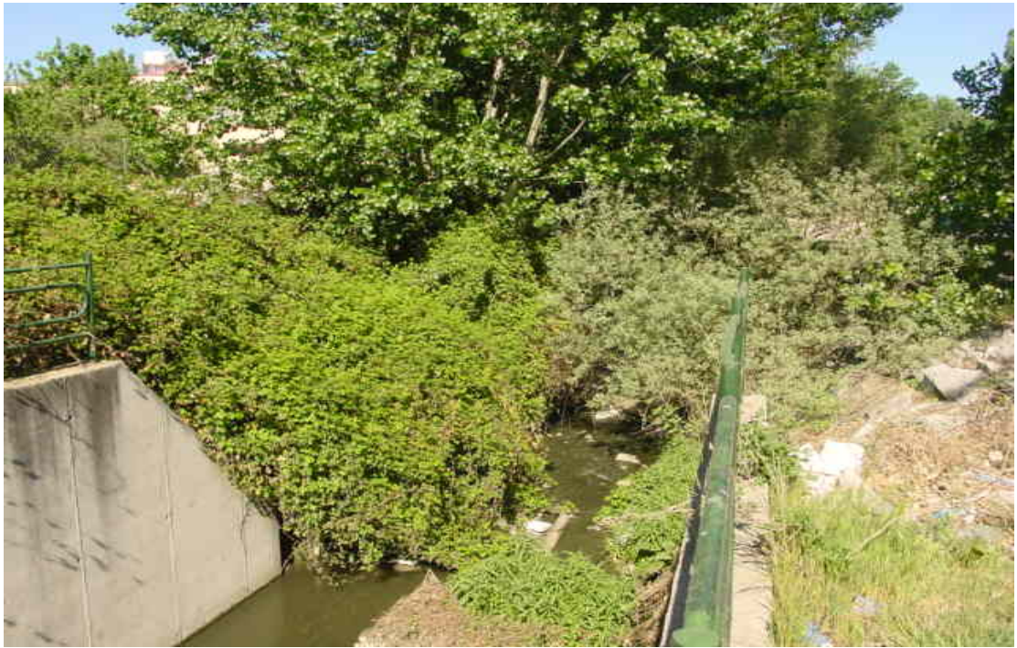
FOTO 6. Vista aguas abajo del arroyo de la Vega, cuyo cauce se encuentra invadido por abundante vegetación herbácea y arbórea.
