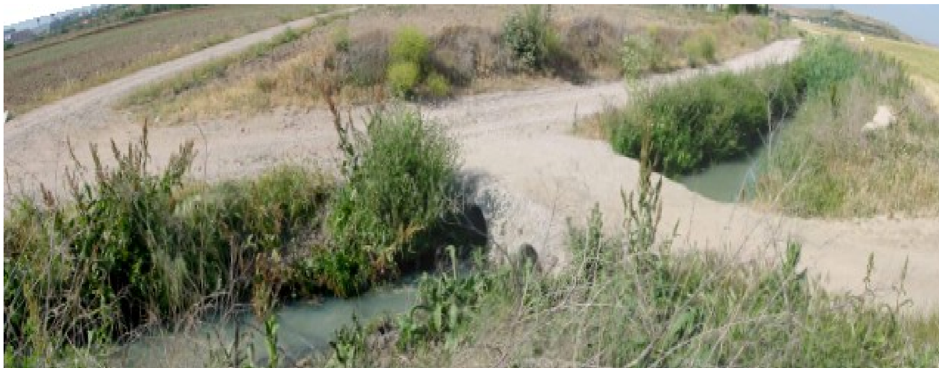
FOTO 1. Cauce del Arroyo de los Carboneros en el cruce con camino local. Obra de paso sobre el arroyo con 2 tubos de 500 mm de diámetro. Pequeño caudal, color oscuro y mal olor.
