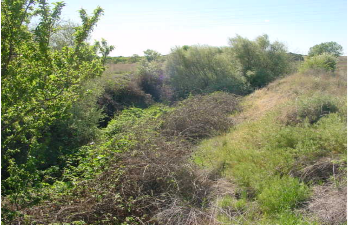
FOTO 2. Vista aguas arriba del arroyo de la Vega en cabecera de cuenca, donde confluye el arroyo de Valdelacasa, el arroyo de la Almenara y el arroyo de la Valdegrulla. El cauce en este tramo se encuentra encajonado con taludes de 45° y una altura media de 3 m., con abundante vegetación tanto en el propio cauce como en ambas márgenes.
