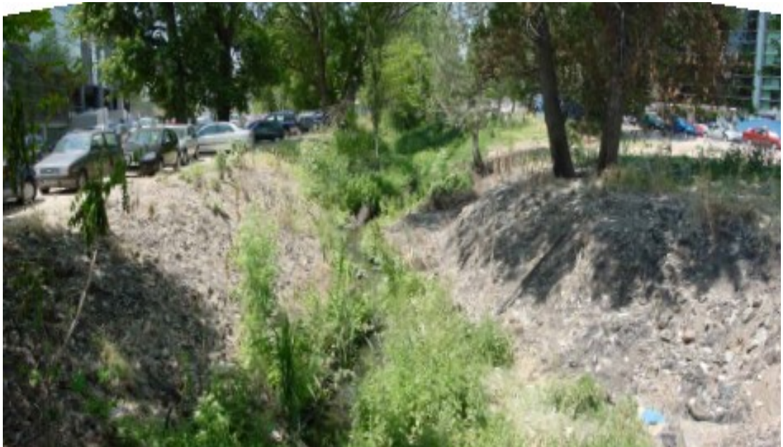
FOTO 7. Sección del cauce del Arroyo de la Vega mirando hacia aguas arriba, desde la O.D. bajo la C/ Valportillo. Se observa la presencia de mucha cantidad de maleza en las márgenes.
