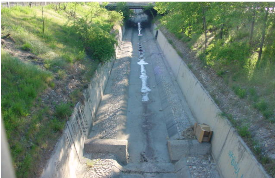
FOTO 17. Detalle del encauzamiento realizado en el entorno del parque urbano, sobre el encauzamiento subterráneo del Arroyo de la Vega. Presenta márgenes revegetadas.
