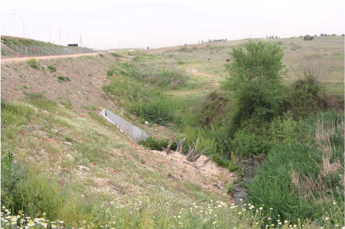
FOTO 4. Vista aguas arriba del arroyo Mesones desde R-2 y aletas embocadura de O.D.
