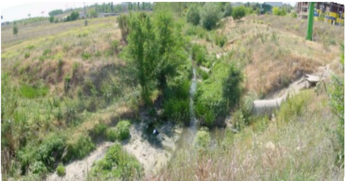
FOTO 24. Vista hacia aguas arriba, desde O.D. bajo la autovía A-1. Cauce cubierto de maleza y arboleda. Cauce muy abierto con taludes muy tendidos.
