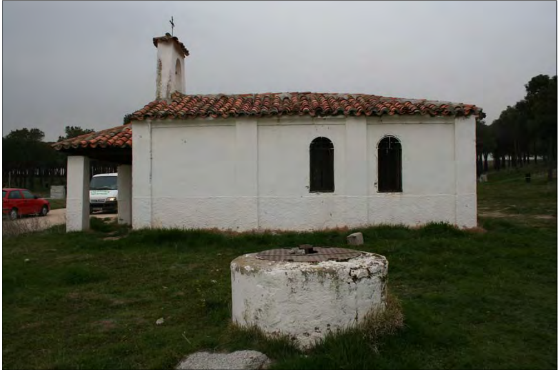
Fig. 05: Vista del lado SE de la ermita.
