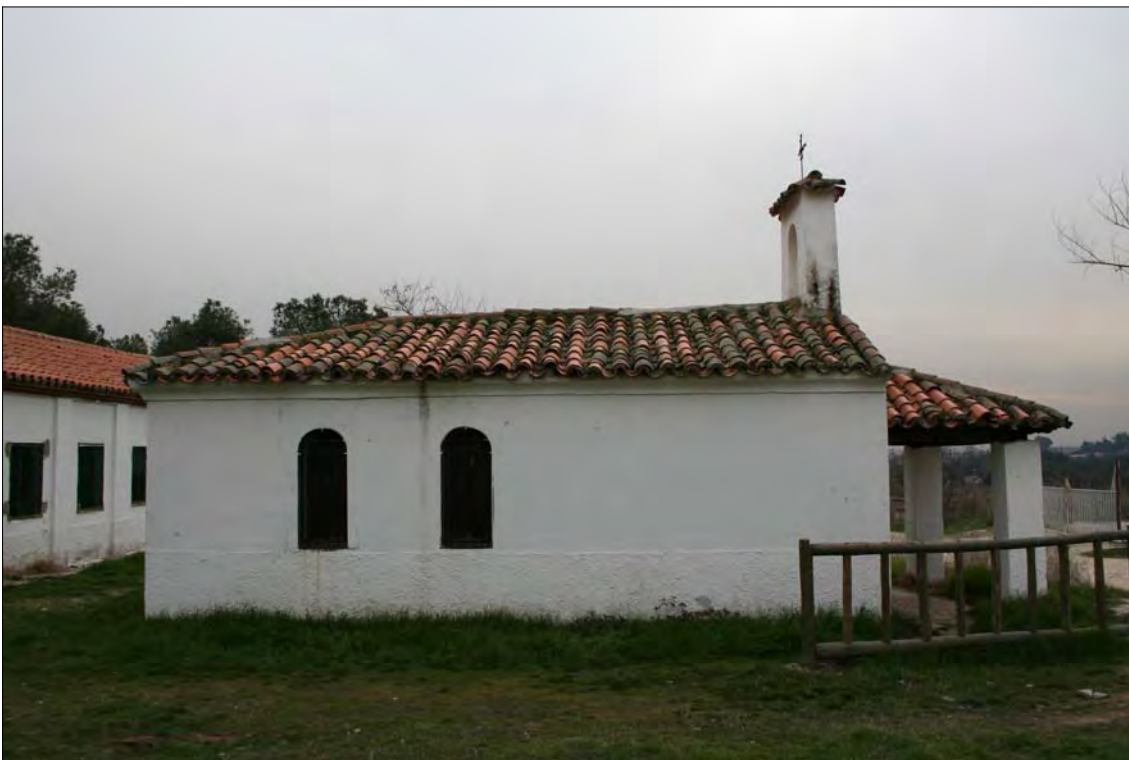
Fig. 04: Vista del lado NW de la ermita.
