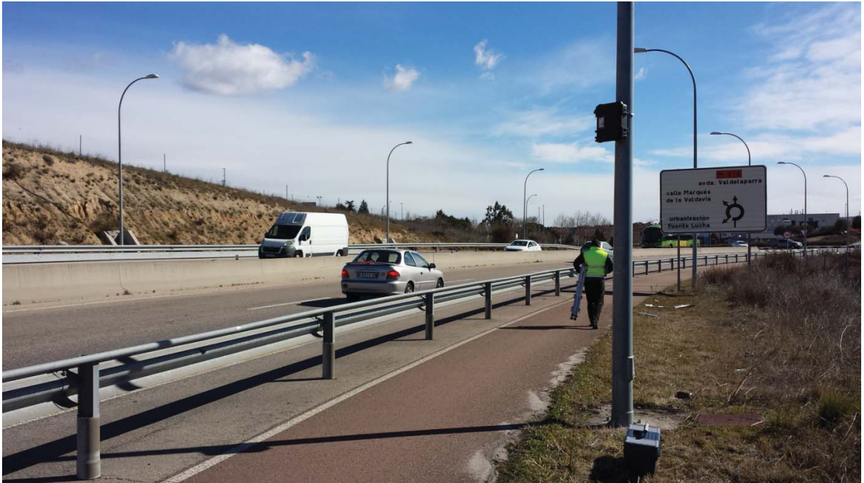
Imagen 5. Detalle 1 de aforo de tecnología radar instalado en M-616.
