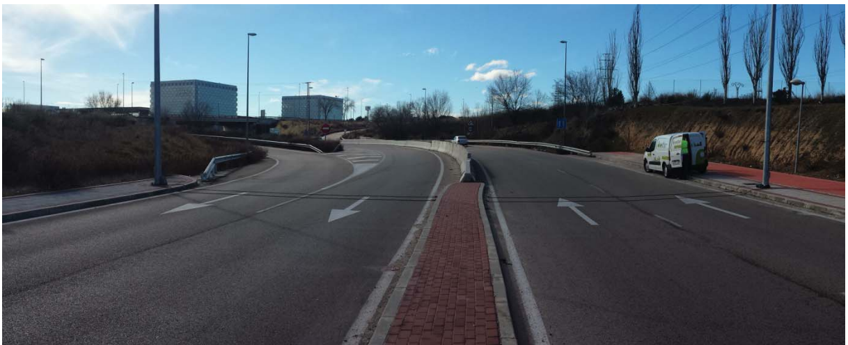
Imagen 6. Detalle 2 de aforo de tubos neumáticos instalado en Camino del Monte Valdelatas.
