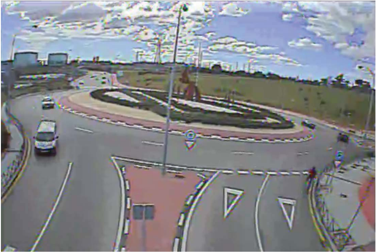
Imagen 15. Detalle 1 de cámara de visión artificial glorieta Avda. del Monte de Latas/Calle de Peñalara.
