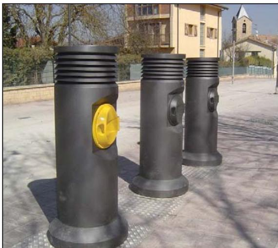
Las compuertas de vertido serán de abertura libre para los usuarios domésticos, con diámetro de 300 mm. Los usuarios comerciales podrán verter con bolsas de hasta 100 litros por compuertas de dimensiones 400 x 400 mm.
