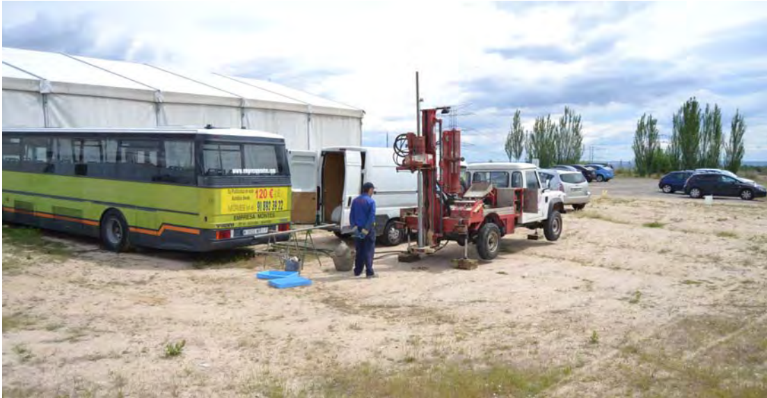
Fotografía 5. Perforación del sondeo S2.
