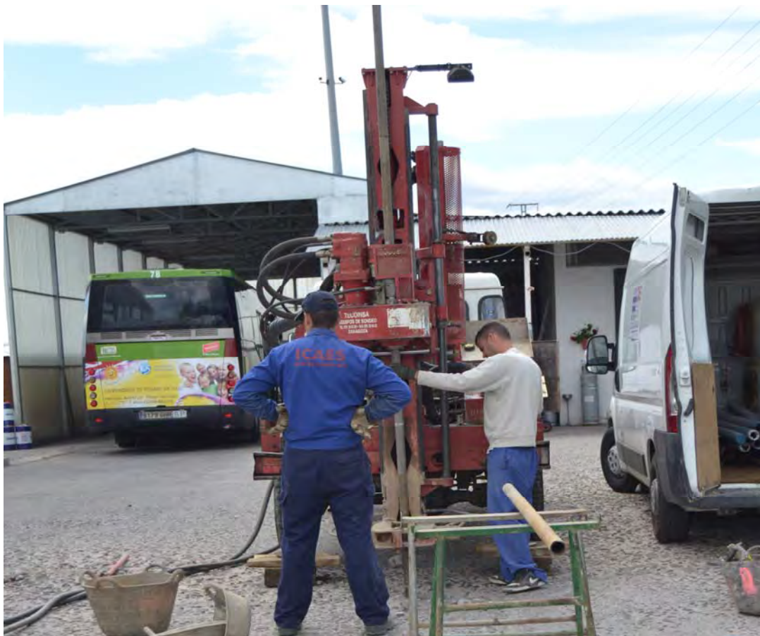
Fotografía 6. Perforación del sondeo S3.
