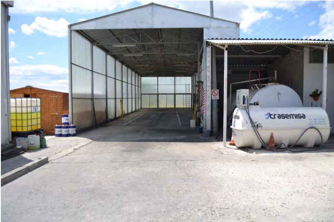
Fotografía 1. Zona de lavado y almacenamiento de combustible.
