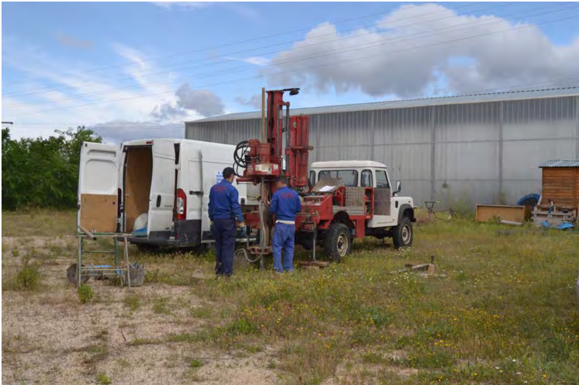
Fotografía 4. Perforación del sondeo S1.
