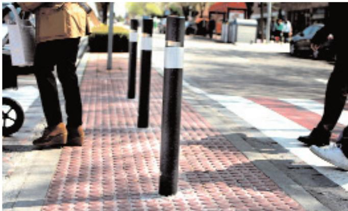
El Ayuntamiento de Alcobendas ha comenzado a instalar en las principales vías de comunicación de la ciudad 1.100 bolardos en los pasos de peatones para evitar que los coches puedan estacionar en ellos. Estos postes metálicos miden 90 centímetros de altura y tienen una banda reflectante en la parte superior para mejorar su visibilidad durante la noche.
