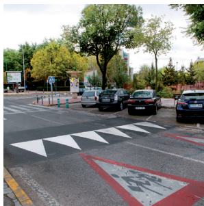
Obras para mejorar la seguridad vial y la movilidad
