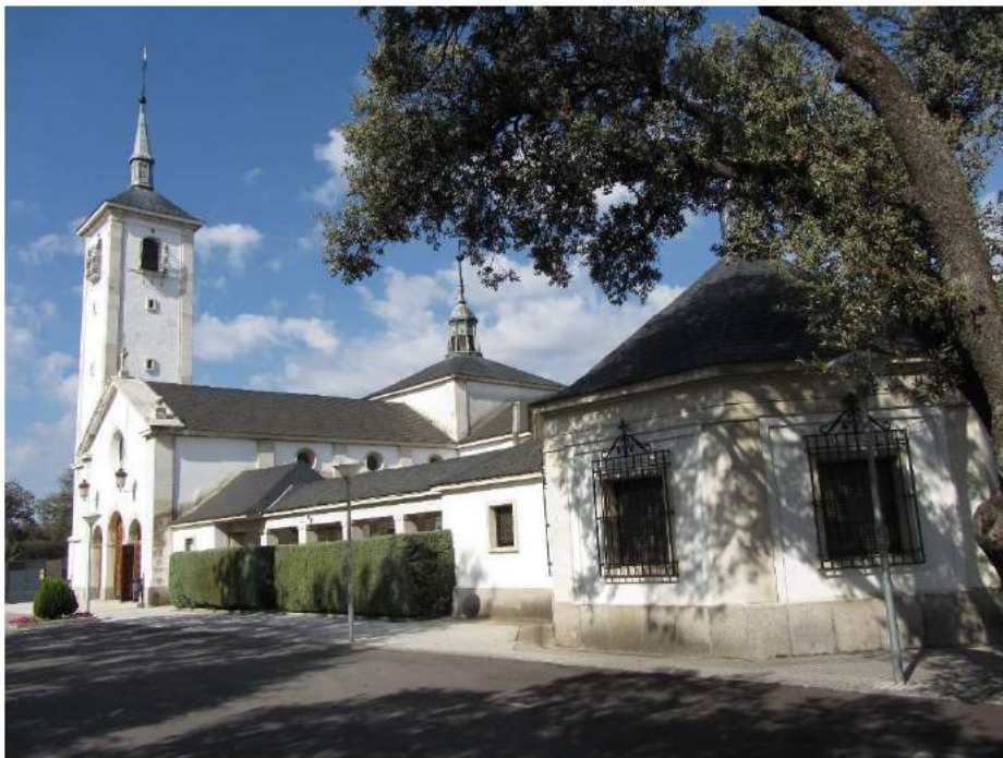
Imágenes exteriores desde el Paseo Conde de los Gaitanes: Iglesia y núcleo de construcciones originales
