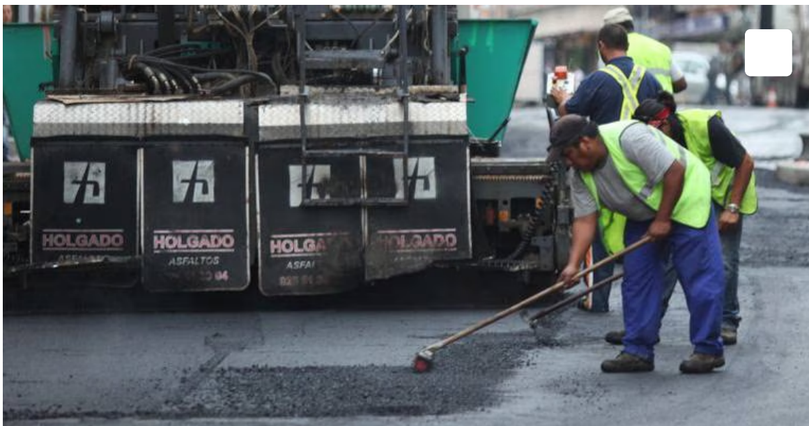
Asfaltado Alcobendas / Ayuntamiento de Alcobendas
