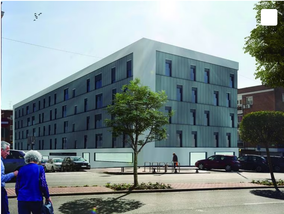
Promoción de 39 viviendas públicas de alquiler en la avenida de España de Alcobendas
